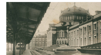
5.駅本屋に隣接した1番線(中央線)電専用ホーム
