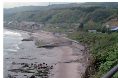
1.撤去される前の緩傾斜護岸
