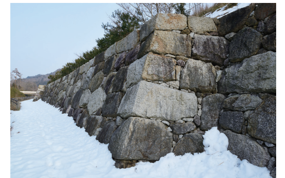
3.新名神高速道路甲南トンネル付近に築かれた見事な穴太衆積の擁壁。もちろん空積み(コンクリートを使っていない)である。上に高速道路が通る。左の雪に覆われた空間は東海自然遊歩道。
