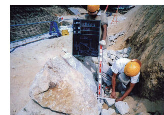
2.現場で下から2段目の石を据えている状況。石の表になる面が天を向いている。
