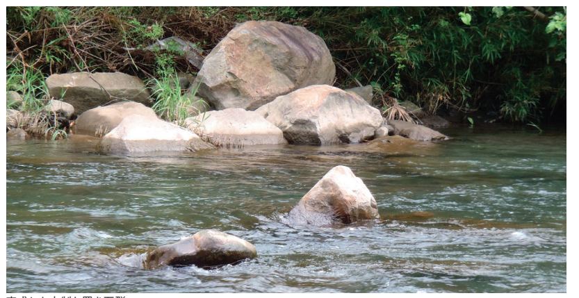
完成した水制と置き石群 増水時に強い流れが集中する場所にと置き石を設けると、流速を増して砂レキを押し流す。その結果、水制の下流に淵が創出された。
