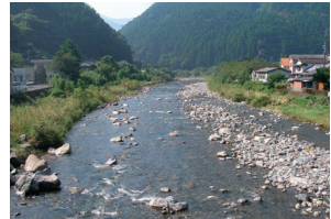
アユの漁獲高が年々減少しつつあった改修前の安田川 全体が偏平に浅くなり、瀬・淵のメリハリがない。
