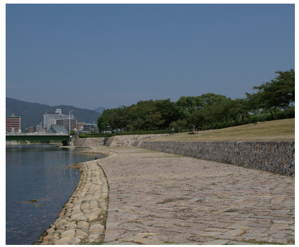
3.都市的にデザインした基町護岸(空鞘橋下流)
