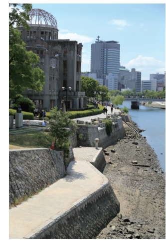
4.原爆ドーム下河岸テラス
