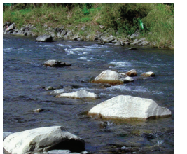
瀬をつくる置き石群 川を斜めに横断して設置した置き石群により、白波の立つ瀬が創出された。
