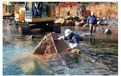
荒廃した河道に瀬と淵を再生するべく実施された試験施工(上右左とも)
