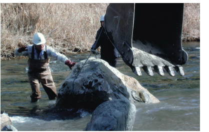
荒廃した河道に瀬と淵を再生するべく実施された試験施工(上右左とも)
