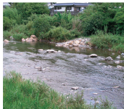
淵をつくる水制・置き石群 中央上に二基の水制工が見え、その先端から下流に静かな水面が見える。静かな水面は淵があることを示している。
