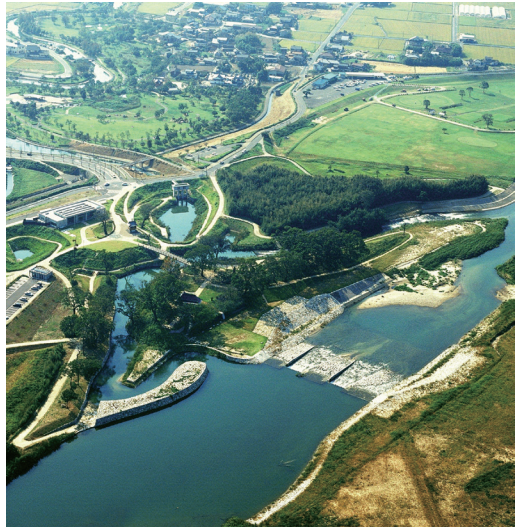
2.石井樋地区全景
