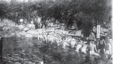
6.石井樋の工事
