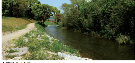
4.放水路と園路
