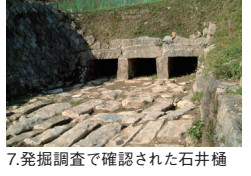
7.発掘調査で確認された石井樋
