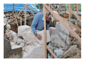
2.石積み作業風景
