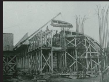
6.防波堤ドーム型枠と鉄筋の設置状況
