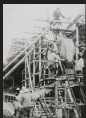
4. コンクリート巻き上げ機による施工
