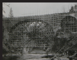
7. コンクリート打設後の型枠撤去前の状況
