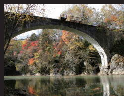
8. 現在の第三音更川橋梁
