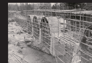
14. タウシュベツ川橋梁施工状況
