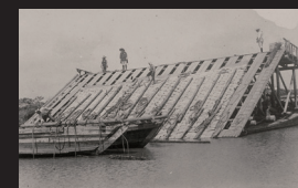
8. 護岸コンクリート単床沈下傾斜台船による施工
