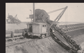
10. エキスカベーターによる新水路掘削(木製の土運車で運搬)
