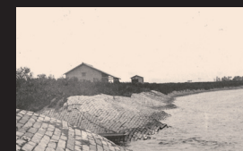
9. 岡崎式単床ブロックによる護岸状況
