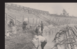
6. 石狩川における岡崎式単床ブロックの施工例
