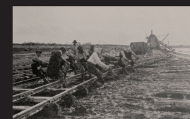
11. 掘削機土取場線路移動作業
