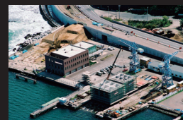
13.現在のケーソンヤード (平成15(2003)年頃)
