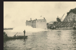
15.ケーソン進水時の状況
