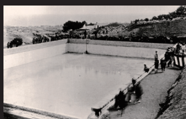
4.元町低区配水池通水状況
