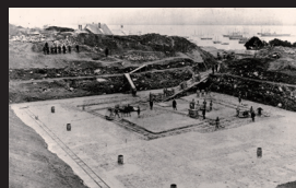
3.工事中の元町低区配水池
