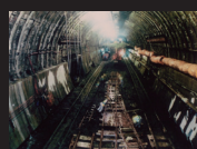
下部掘削後の全景
