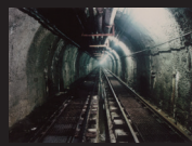
先進導坑の全景
