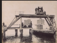
10. 工場栈橋からのコンクリート塊積出
