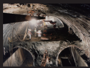
サイロット工法全景
