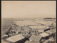
11. 船入場築造と埋立工事状況
