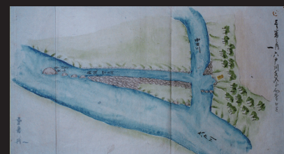
6.新渡戸開発時の稲生川頭首工(安政年間)
