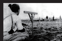
8.測量中の状況
