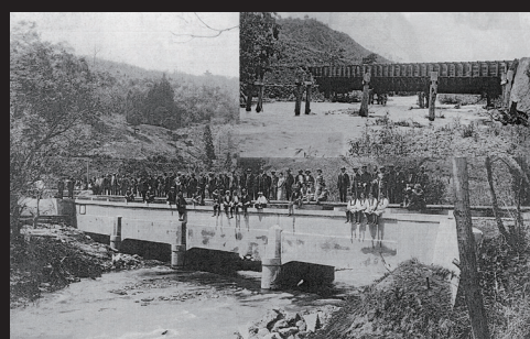
12.昭和8(1933)年ごろの熊ノ沢川掛樋改良工事 旧水路掛樋(右上)
