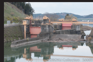
9.脇谷洗堰及閘門
