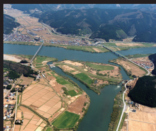
2.平成12(2000)年ごろの北上川分流地点 右が新北上川、下が旧北上川。 分流地点の左に鴉波洗堰、右に脇谷洗堰が見える。
