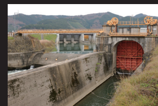
10.脇谷閘門とその上流側に 平成19(2007)年に完成した脇谷水門
