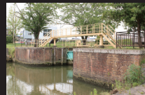
13.被災前の石井閘門（平成21（2009）年撮影）
