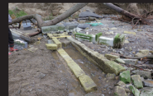
14.北上運河と鳴瀬川との合流点の堤防護岸 津波被災により凝灰岩の石積みの悪水吐噴渠が発見された。（平成23（2011）年6月撮影）
