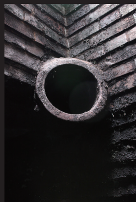
10.レンガ造り人孔(マンホール) レンガは伊勢久治郎の工場製品(仙台市太白区あすと長町、工場は現存しない)
