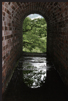
9.馬蹄形レンガ下水渠 明治32(1899)年度の第二期工事で建造された馬蹄形レンガ下水渠及び矩形レンガ下水渠300間(545m)、馬蹄渠の底石は鋼砂粘板岩の稲井石(石巻市稲井産)
