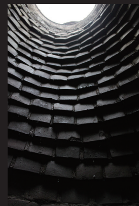
11.レンガ造り人孔(マンホール) 人孔の出入口の縁石は花崗岩(宮城県丸森町産)
