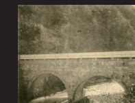
16.旧熱海疏水橋
