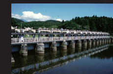
14.現在の安積疏水十六橋水門
