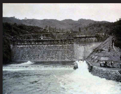
1.堤上架橋工事風景 (明治44(1911)年)
