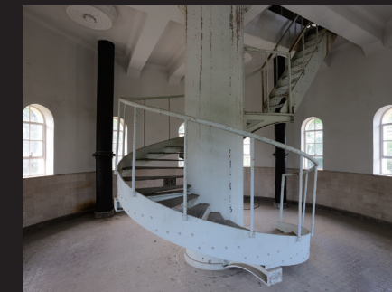
10.配水塔内部(1階)
