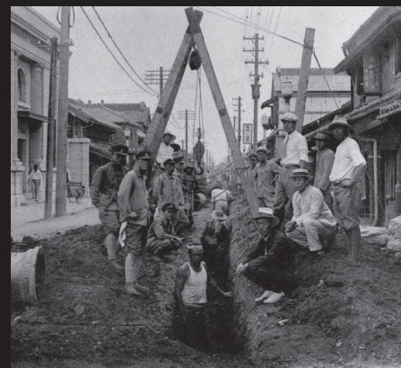
4.市内の水道工事の様子
