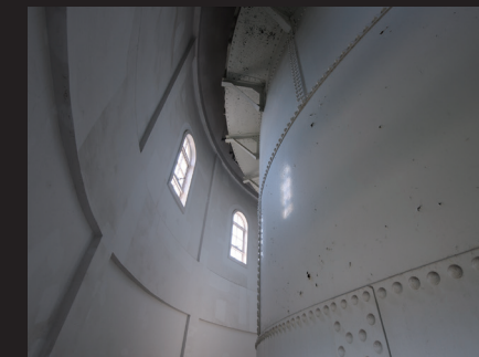
8.配水塔の内部(右が水槽)
