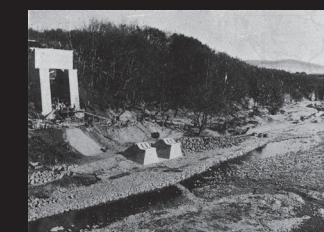
4.左岸橋台完成時の状況
