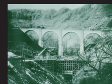
3.碓氷アプト式鉄道(竣工直後の碓氷第3橋梁)
