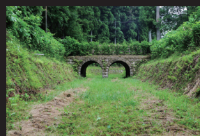
3.旧取水口付近の導水路(那須疏水公園)
