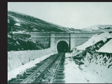
6.碓氷アプト式鉄道(竣工直後の碓氷第26トンネル出口)
