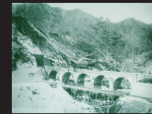
7.碓氷アプト式鉄道(竣工直後の碓氷第13橋梁)
