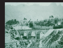
4.碓氷アプト式鉄道(霧積川橋梁)
