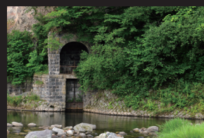
4.切石布積の石組み水門(第三次取水口)
