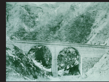
5.碓氷アプト式鉄道(竣工直後の碓氷第17橋梁)
