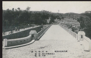
3.竣工当時の秩父橋正面
