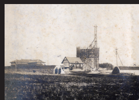
6.工事中の2号配水塔
