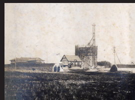
6. 工事中の2号配水塔
