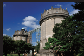
7. 現在の配水塔
