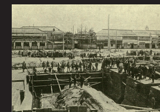
10.基礎コンクリート上に煉瓦造アーチ基部施行中の状況
