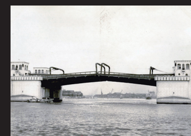
開閉していた当時の勝鬨橋①
