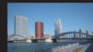
現在の勝鬨橋
