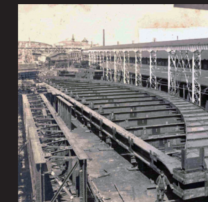
鋼桁工場製作
