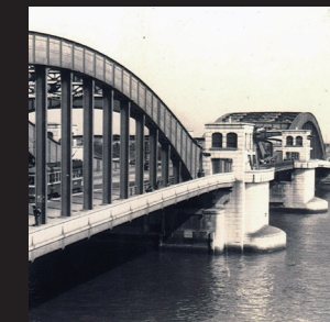
完成後の勝鬨橋
