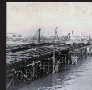
桁架設用作業構台組み立て
