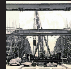
側径間アーチ部架設②
