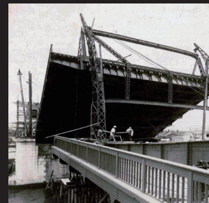
可動桁架設②
