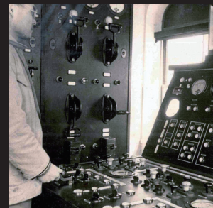
可動用運転室
