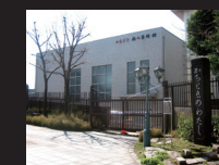
旧勝鬨橋変電所 「かちどき 橋の資料館」
