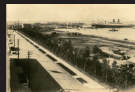
9.工事中の山下公園
