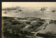
10.工事中の山下公園
