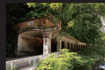
7.現在の函嶺洞門
