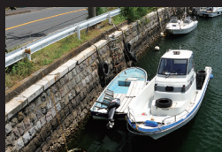
6.震災後の改修で築造された石積護岸
