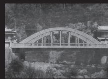
3.竣工当時の千歳橋
