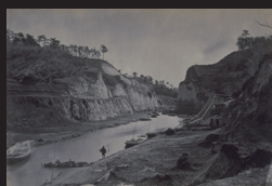
4.開削工事の状況
