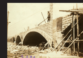
10.アーチ部架設工事の状況
