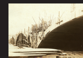
9.アーチ部架設工事の状況
