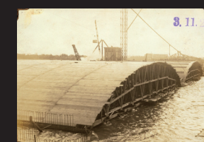
8.アーチ部架設支保工
