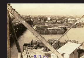
7.橋脚工事の状況
