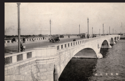
4.竣工当時の写真
