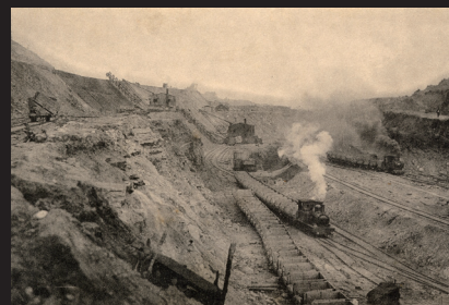
5. 山間部の放水路開削工事の状況
