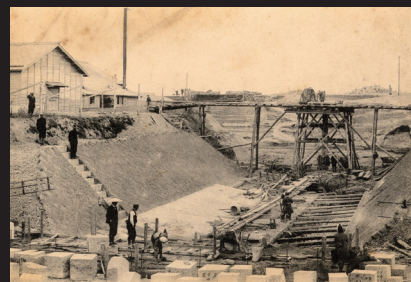
4. 建設中の大河津開門
