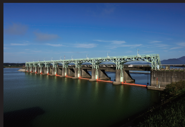
10. 撤去前の大河津可動堰(上流側)
