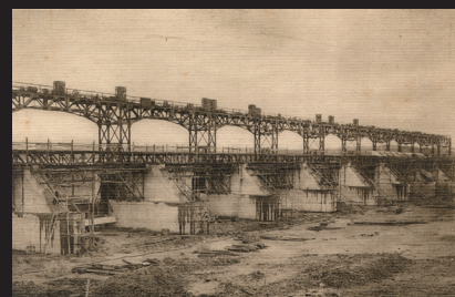
2. 建設中の大河津可動堰
