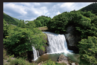
10.現在の勝沼砂防堰堤(下流側)
