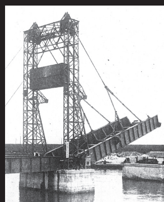
4. 可動桁の試運転の様子(昭和6(1931)年12月4日)
