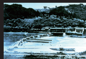
10. 供用時の明治用水旧頭首工 右岸側からの風景。手前に導水堤がある。堰堤の向こうに船通樋(開門)が見える。開門扉に船の操作を待つ時間を過ごすためか、店らしきものがある。
