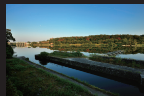
11. 現在の明治用水旧頭首工の遺構 左岸側からの風景。手前に船通樋(開門)の遺構があり、写真右上へ向かってアーチ型堰堤が伸びていた。下流側(左奥)に見えるのは、現在使用されている新しい頭首工。
