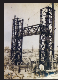
3. 建設時の松重開門
