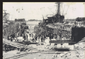
2.建設中の中島閘門
