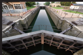
5.閘室内 (リベット接合と水密部の榫)
