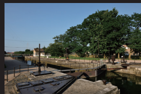
4.現在の中島閘門
