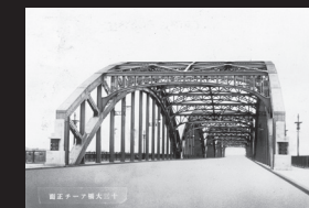
1.竣工当時の十三大橋
