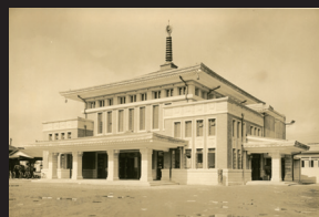
3.竣工時の奈良駅舎
