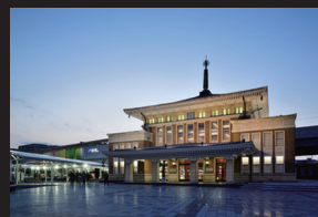
4.現在の奈良駅舎 曳屋によって動かされ観光案内所として使用。
