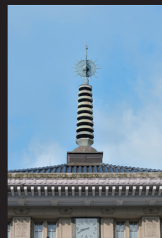
5.現在の奈良駅舎 緩やかな傾斜屋根と和風様式が調和する。
