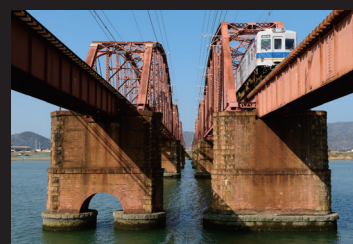
2.現在の紀ノ川橋梁
