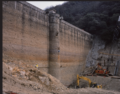
4. 布引五本松堰堤 堤体(前面、水抜き補修工事)
