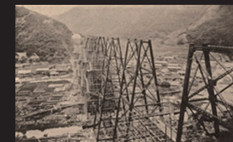
3. 余部橋梁工事写真 (明治44(1911)年8月22日)
