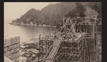
4. 余部橋梁工事写真 (明治44(1911)年9月25日)
