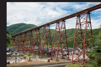
5. 余部橋梁(旧橋)
