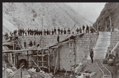
3. 堰堤建造工事内側ヨリ撮ス
