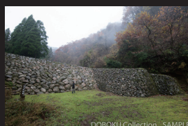
5.松ヶ端堰堤(6号堰堤)の巨石積み
