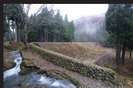
7.土で突き固められた8号堰堤
