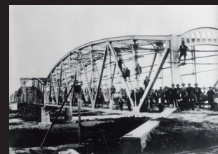
4.建設中の日野橋
