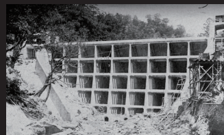
5.竣工直前の三滝ダム
