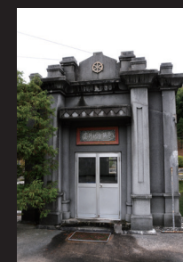
17. 忌部浄水場の濾過池調整弁室(拡張期)
