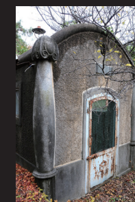
19. (旧)床机山配水池の計量室
