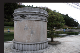
15. 忌部浄水場の濾過池調整弁室(創設期)
