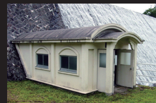
14. 千本堰堤の弁室
