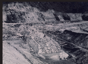
4. 建設中の千本堰堤
