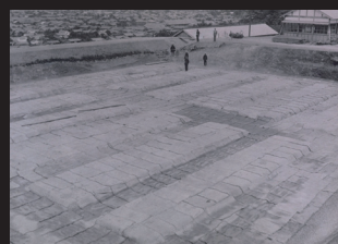
8. 基礎工事中の床机山配水池
