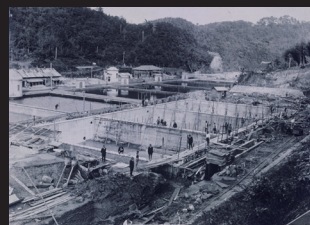
6. 拡張工事中の忌部浄水場
