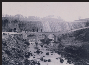
5. 竣工時の千本堰堤
