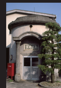
18. 忌部浄水場の集合弁室
