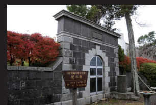
16. (旧)床机山配水池の入口
