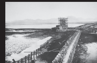
18.建設中の樋門と堤防
