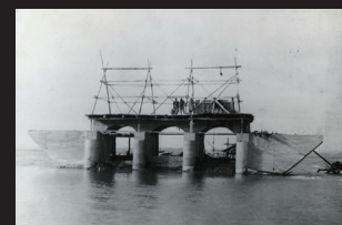
17.建設中の第六区第四号樋門
