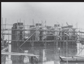
3.建設中の丙川三連樋門
