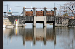
19.現在の第六区第四号樋門
