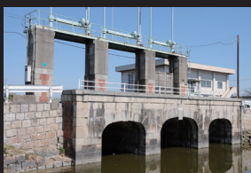
5.現在の丙川三連樋門
