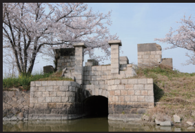
6.現在の片崎樋門
