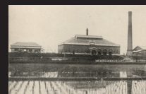
3. 竣工時の三野浄水場動力室・ポンプ室
