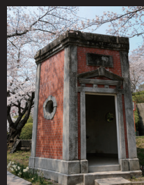
11. 現在の半田山配水池(旧)量水室
