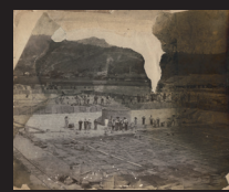
2. 工事中の三野浄水場濾過池
