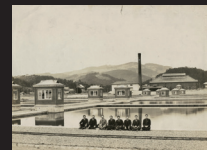
4. 第二期拡張工事竣工時の三野浄水場
