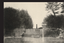
1. 竣工時の取水樋門
