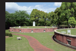
15. 現在の半田山配水池
