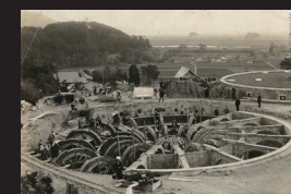
12. 第一期拡張工事中の半田山配水池
