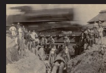
5. 半田山配水池への送水管敷設工事
