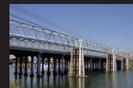
16. 現在の京橋水管橋
