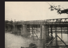
13. 竣工時の京橋水管橋
