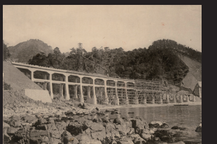
5.工事中の惣郷川橋梁
