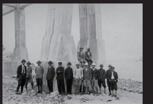
6.竣工後の惣郷川橋梁
