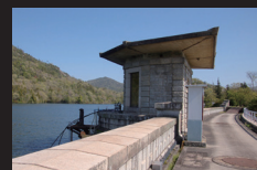
6.堰堤上部の貯水塔上屋
