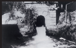
7.旧呉鎮守府水道二河川取入口
