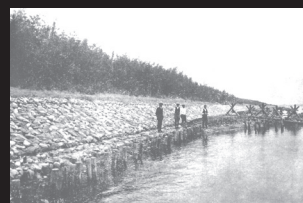
4.金網蛇籠による護岸工事
