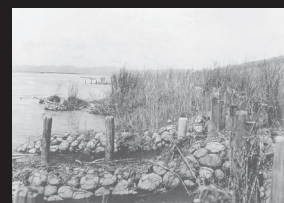
5.低水工事で整備した水制工
