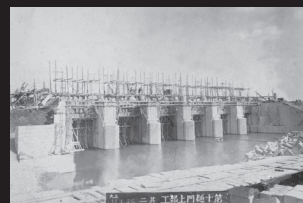
6.工事中の第十樋門
