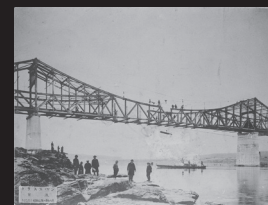
11.吊桁をケーブルで吊り足場無しで施工している
