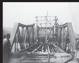
9.片持ち梁の工事風景
