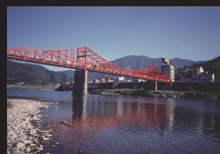
5.解体前の穴吹橋
