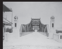
10.竣工直後の様子
