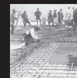
配水池覆蓋 鉄筋立工事
