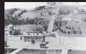
竣工時の旭浄水場全景
