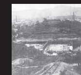
配水池の置かれた 御殿山より濾過池を望む
