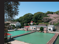
近年の旭浄水場全景 (現在は更新工事中)
