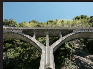
5.アーチと橋脚
