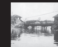
桜井橋水管橋
