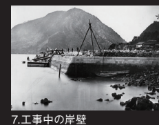
7.工事中の岸壁
