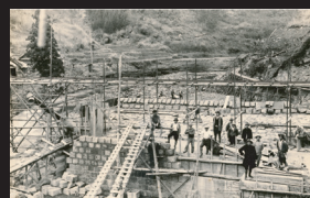
5.建設中の右岸部
