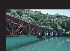
6.トラス橋とRC方杖ラーメン橋
