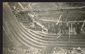
7.建設中の左岸階段部
