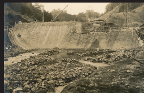
9.半川締切工法による堤体建設②
