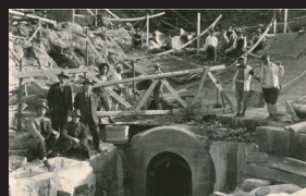
6.堤体右岸下流部流出口と三次元曲面
