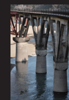
5.低水位時の 橋脚の様子
