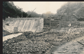
8.半川締切工法による堤体建設①
