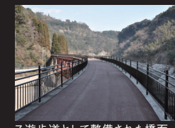
7.遊歩道として整備された橋面
